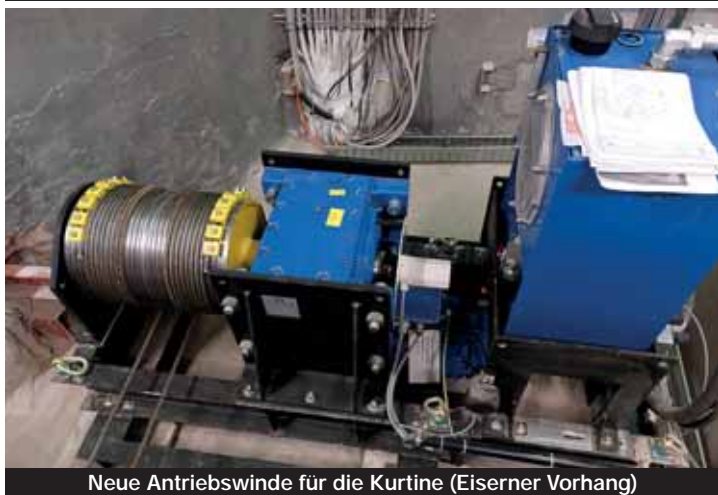
Inbetriebnahme einer neuen Winde mit Schnürboden
